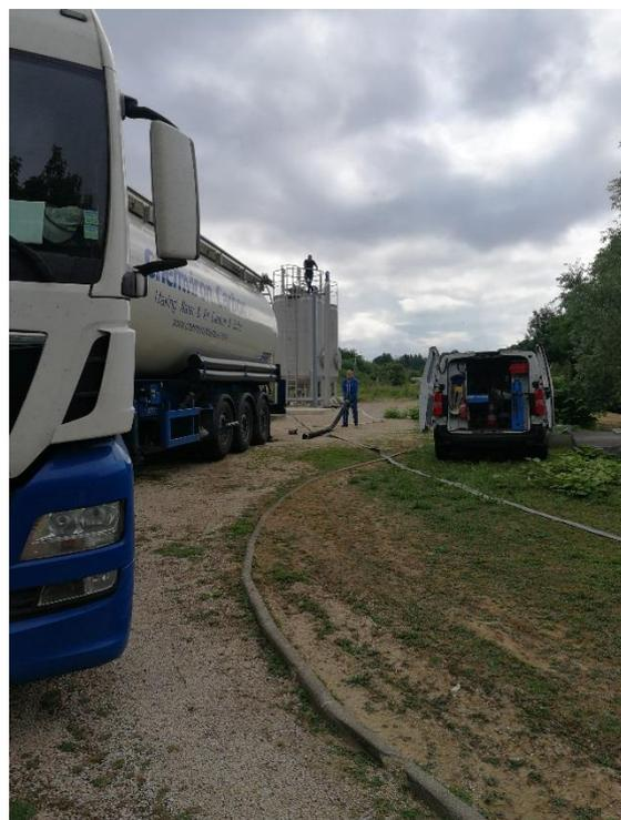
Figure 2- Remplissage du charbon actif
