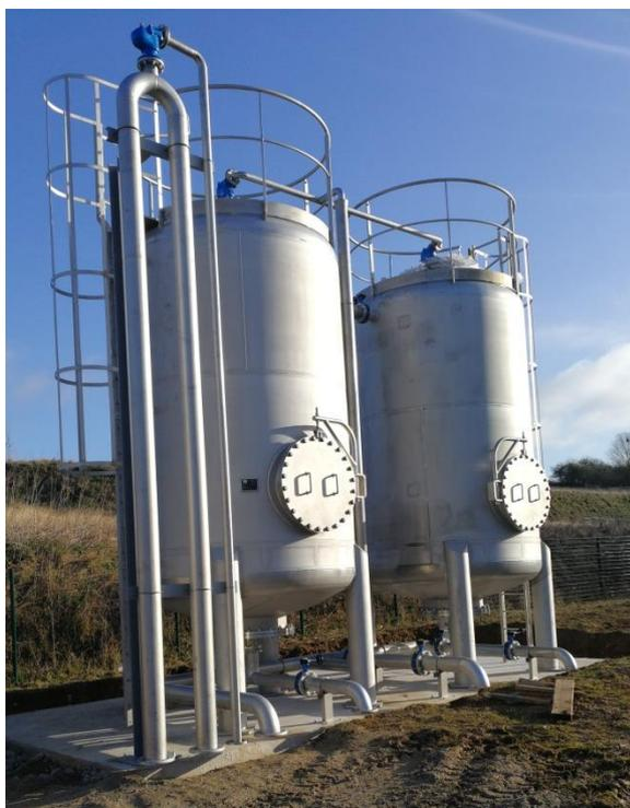
Figure 1- Pose des tours de filtration
