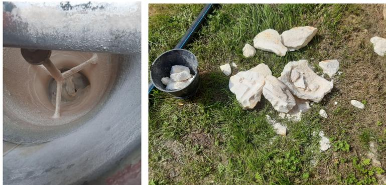
⇒ **13/12/2022** Semaine de gel qui a provoqué la cristallisation de la soude (à 12°). Installation d' un cordon chauffant afin de faire repartir le niveau de TH.
