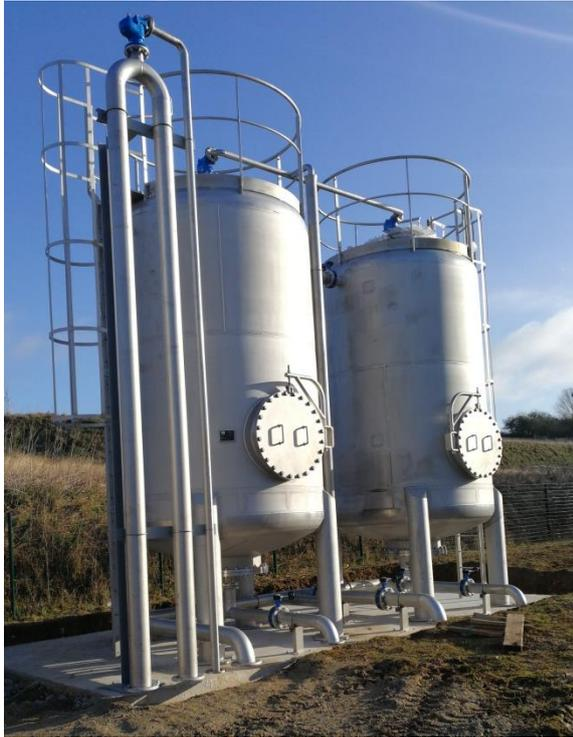
Figure 1- Pose des tours de filtration
