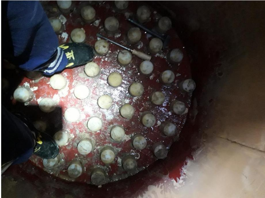
*Vue du plancher crépiné du réacteur après nettoyage*
