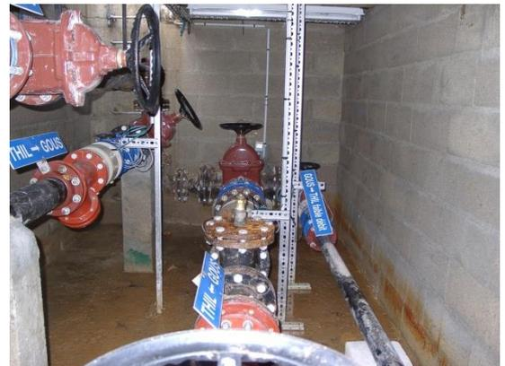
L'interconnexion entre Goussainville et le Thillay, située au rond-point du Bassin, a été automatisée pour une ouverture immédiate en cas de baisse de pression sur ce réseau.
